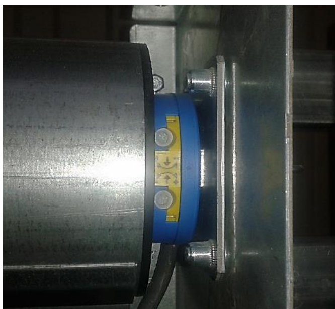
Fot. 1 Widok na elementy regulacyjne wyłączników krańcowych silnika kurtyny (górną i dolną pozycją).
